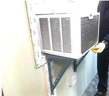
창호 일체형 에어컨 설치 예시
