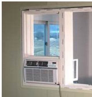
창호 일체형 에어컨 설치 예시
