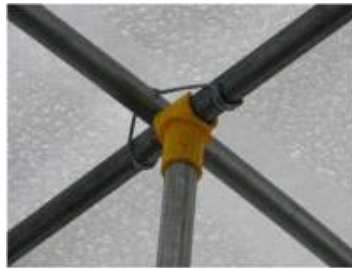
<보강지주 설치 전경> <도리와 보강지주의 연결> <바닥 지지판>
