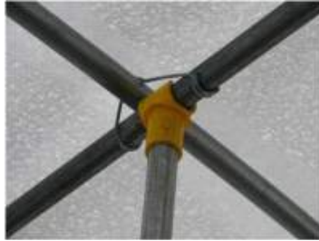
<보강지주 설치 전경> <도리와 보강지주의 연결> <바닥 지지판>
