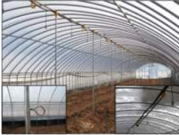
<보강지주 설치 전경> <도리와 보강지주의 연결> <바닥 지지판>
