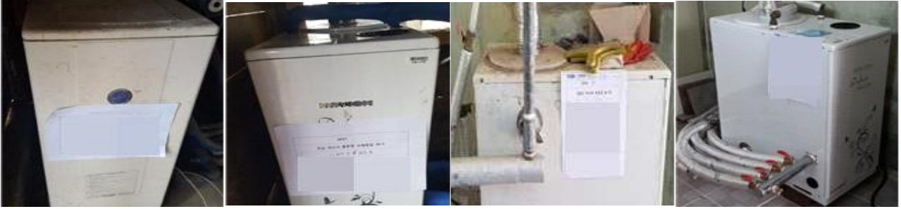
<기존 보일러 확인 → 보일러 철거 → 보일러 교체 설치> (왼쪽부터 가스보일러 시공 전/후, 기름보일러 시공 전/후)
