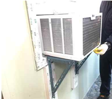
창호 일체형 에어컨 설치 예시
