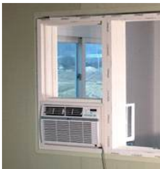
창호 일체형 에어컨 설치 예시
